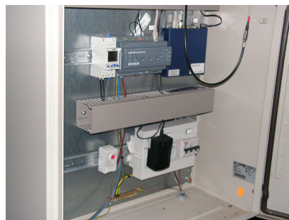
Фиг.5. WEB-базиран сегментен контролер в захранващ блок за улично осветление (Осло, Норвегия) [2]
